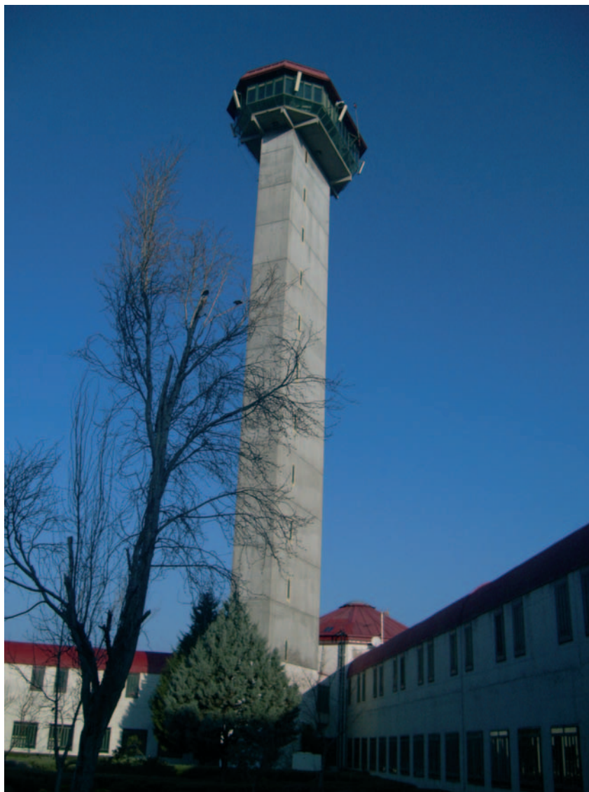
Centro Penitenciario Madrid III (Valdemoro)
