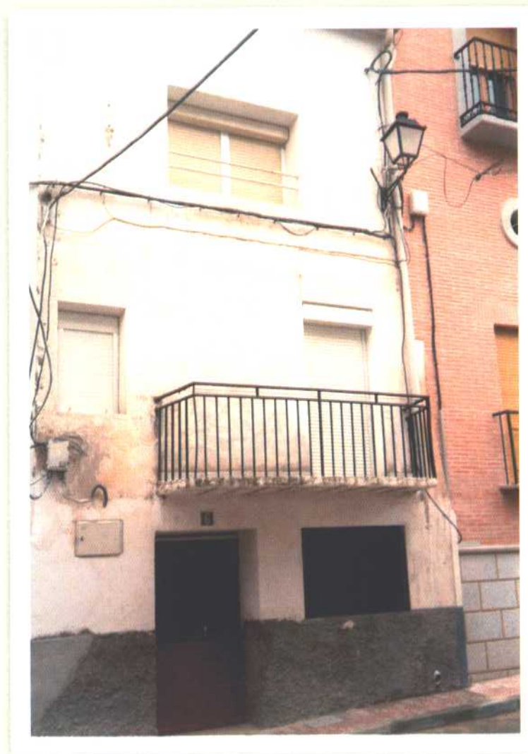
Almoquera (Guadalajara). Marca de la altura que alcanzó el agua (Foto. L. Sáenz de San Pedro)
