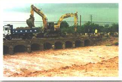
Derribo puente Cartagena-Murcia (Foto. Sofía González)
