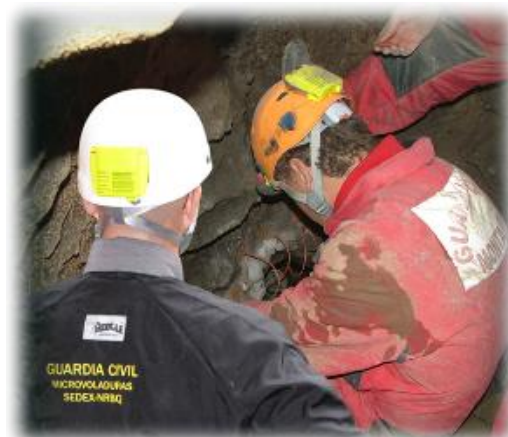
Imagen de una práctica de microvoladuras
