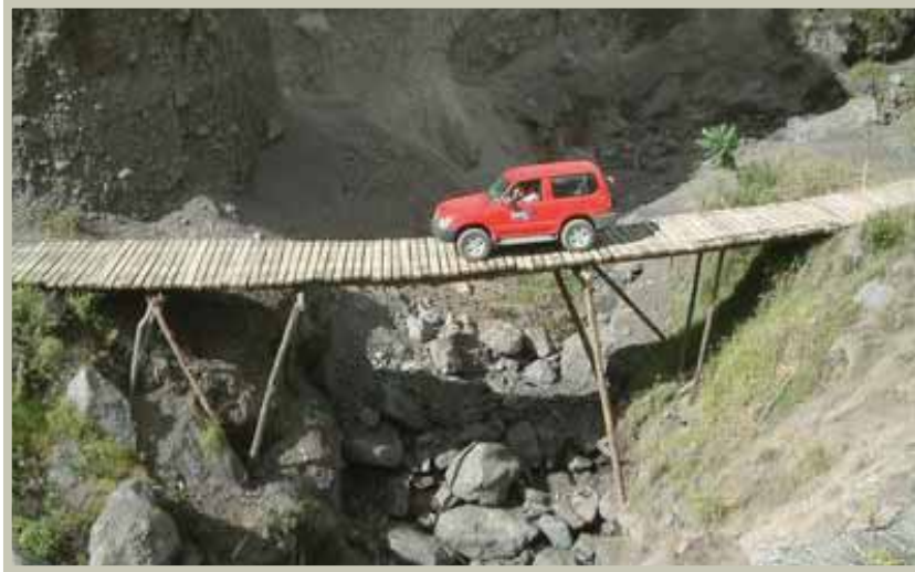
Puente provisional para cruzar el corte producido en la carretera por un lahar del volcán Tungurahua (Ecuador). Foto R. Ortiz.
