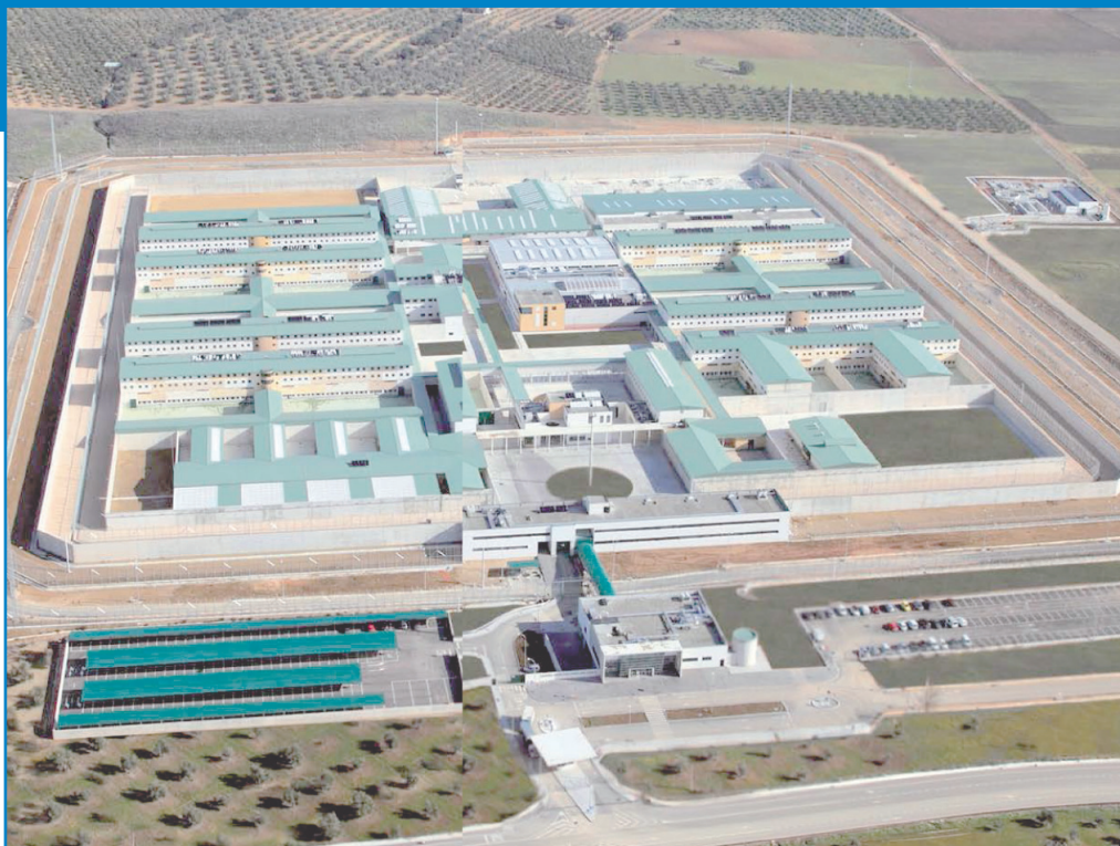
Centro Penitenciario Málaga II
