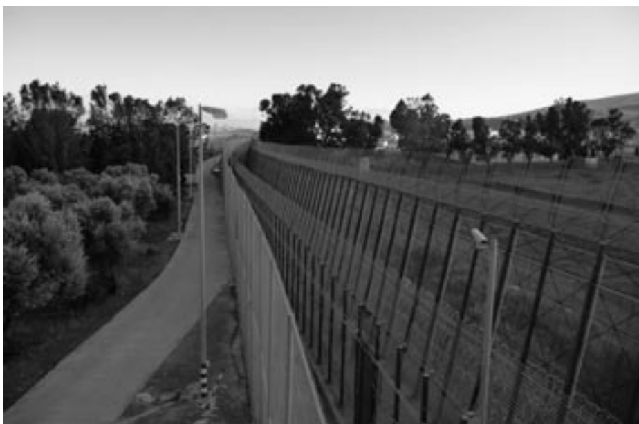
Figura 12. Vallado perimetral fronterizo de Melilla
