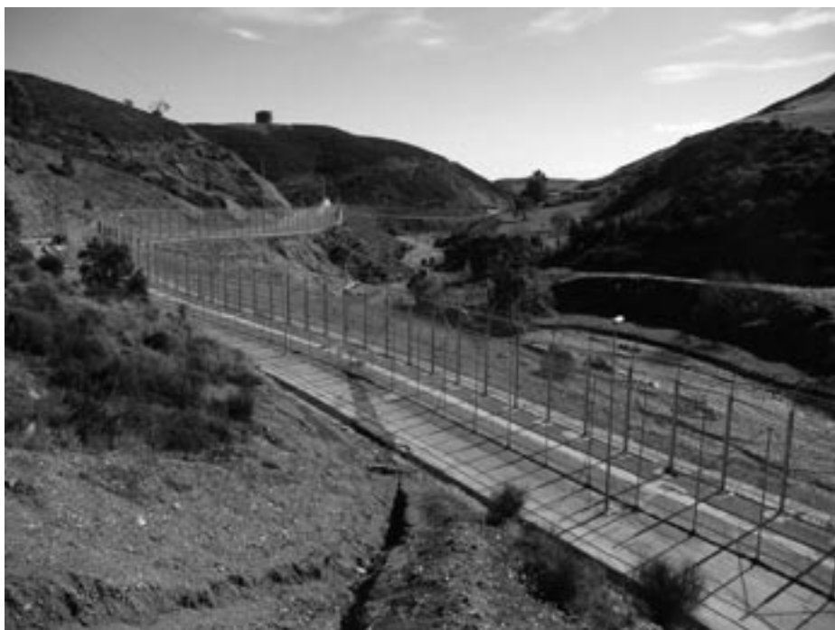
Figura 34. Vallado perimetral fronterizo de Ceuta
