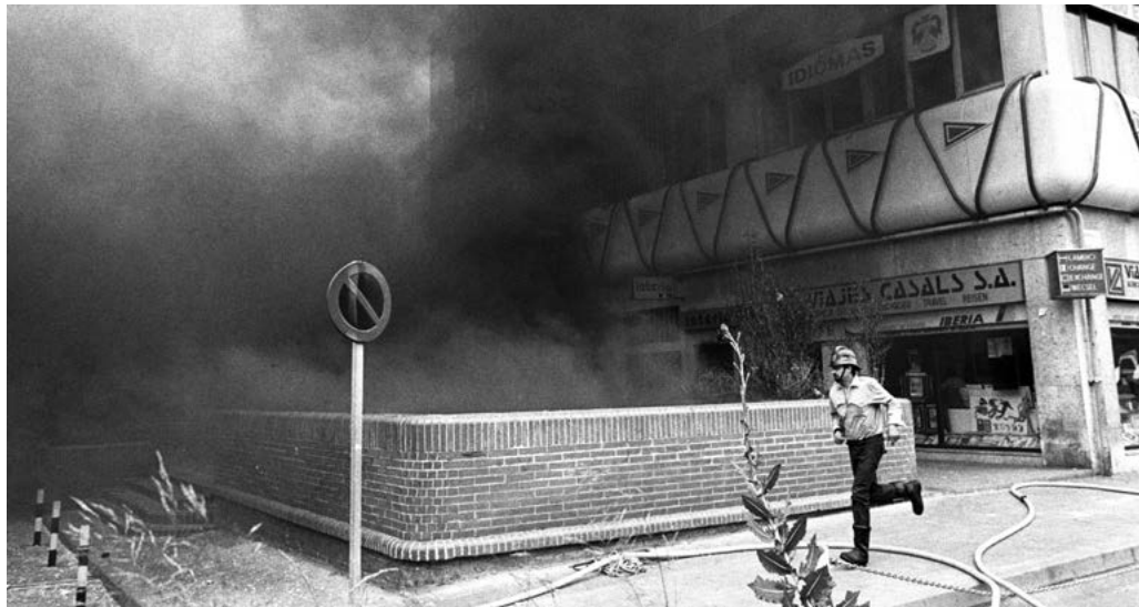
Fig. 14. Bomberos intentan acceder al interior del aparcamiento del Hipercor de Barcelona afectado por una explosión de ETA (19/06/1987). Fotografía: EFE.
