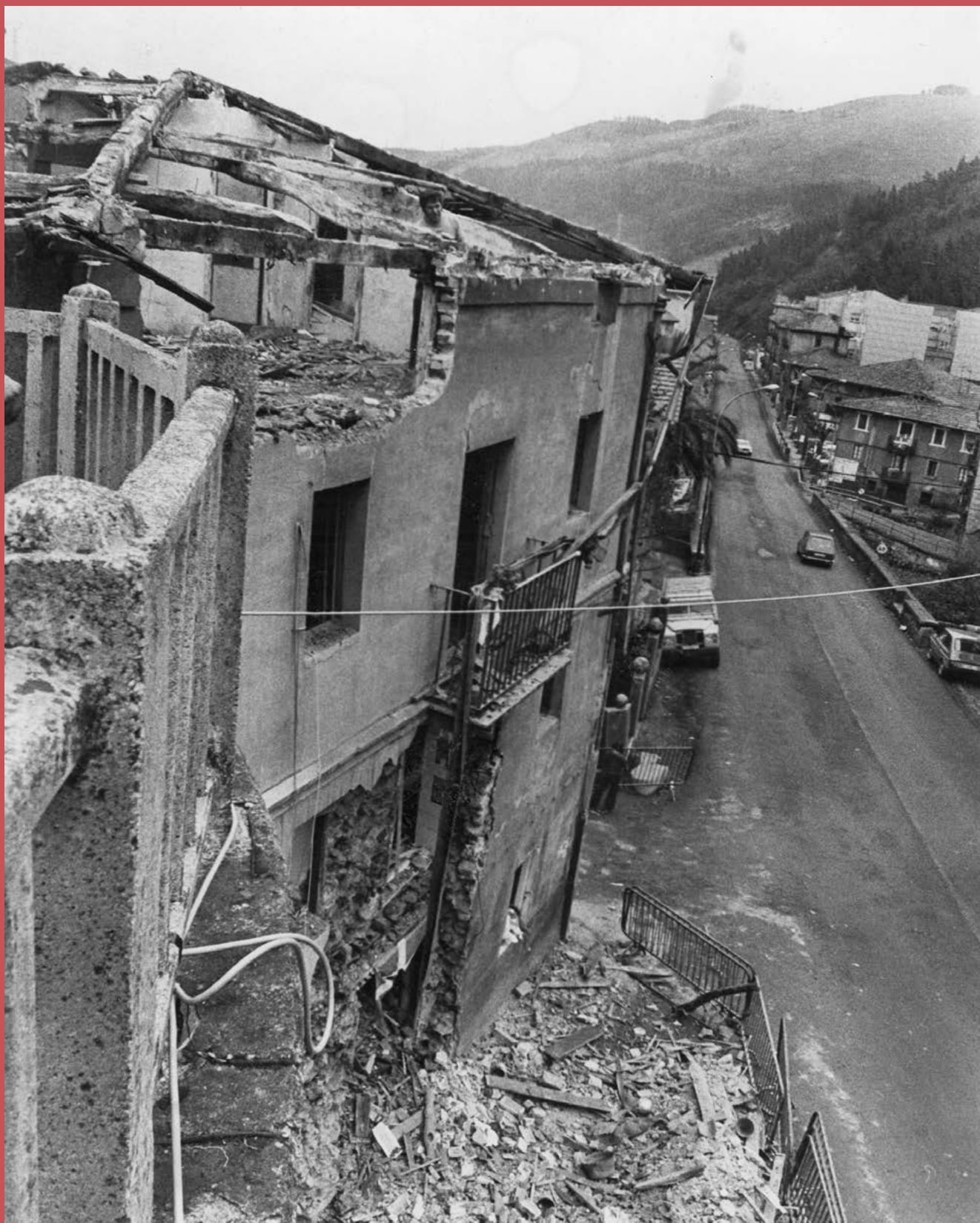
Fig. 11. Edificio donde se situaba el bar Aldana, completamente destrozado tras un atentado cometido por la extrema derecha (20/01/1980). Fotografía: AMB, Fondo de La Gaceta del Norte.
