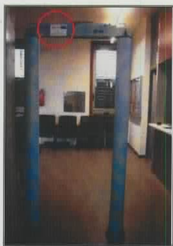
Arco detector de metales ubicado en la Sección Consular de España en Malabo
