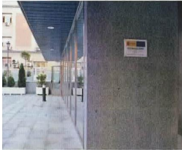
Placa fachada del edificio colocada a la finalización de las obras
