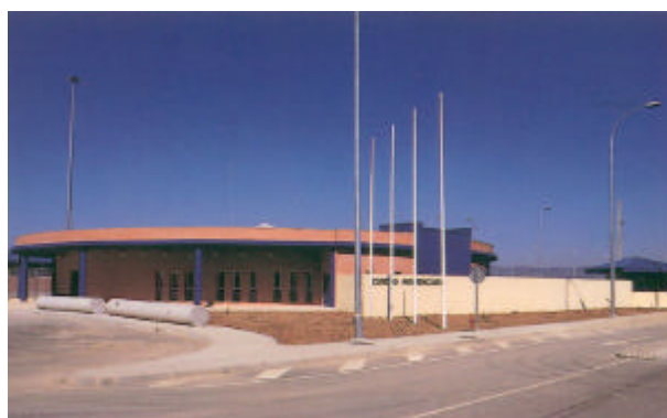
Centro Penitenciario de Córdoba
